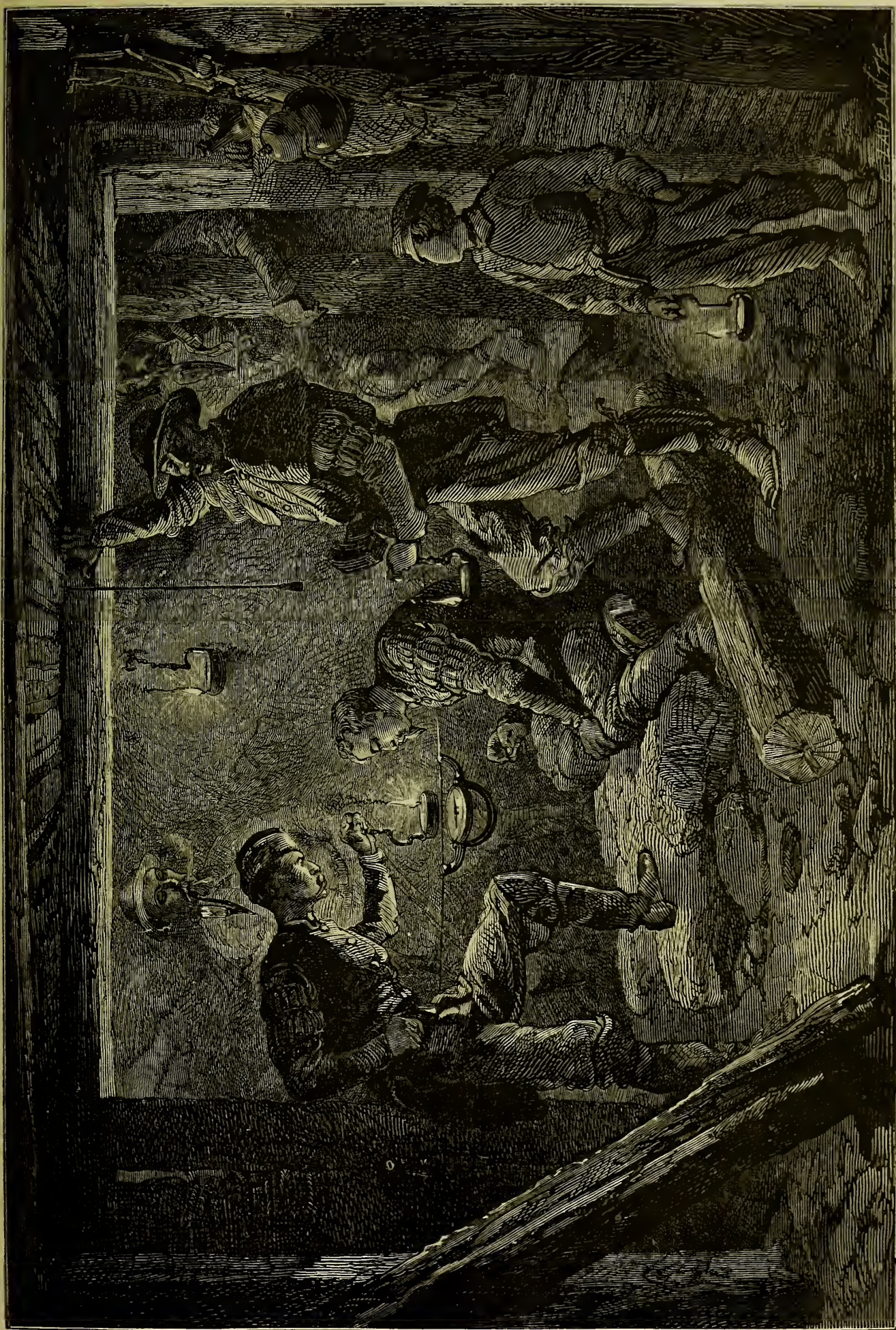
Fig. 113. — La levée du plan à la boussole dans les mines de la Vieille-Montagne, d'après F. Bonhomme.
